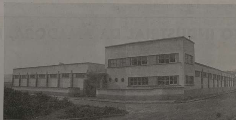
VISTA GERAL DA FÁBRICA
