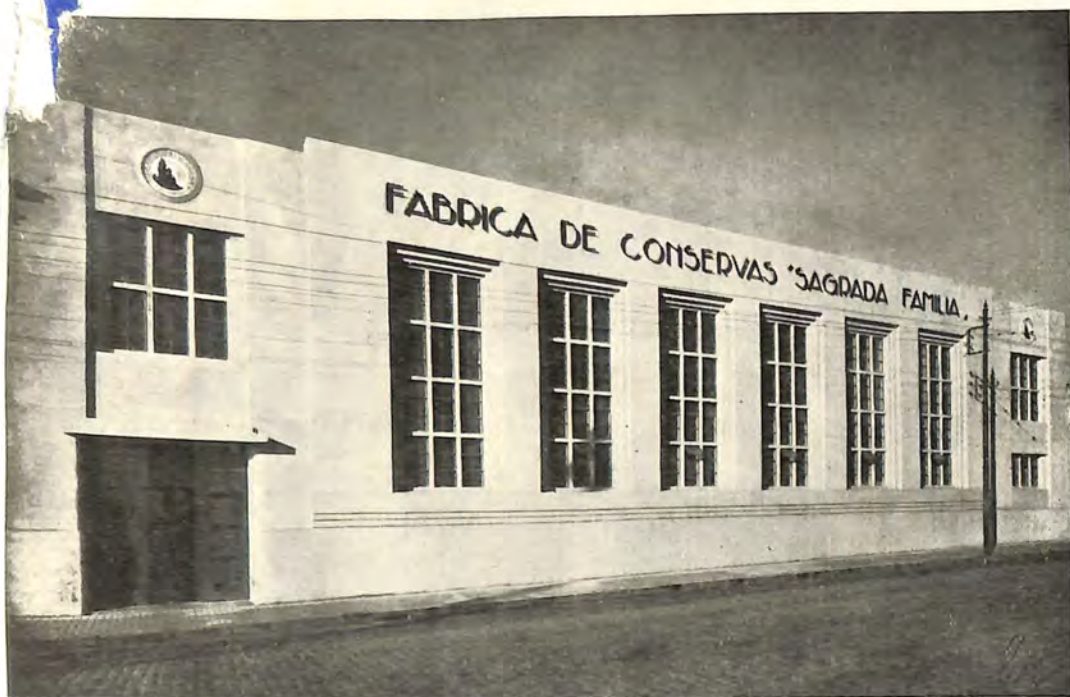
FACHADA PRINCIPAL DA FÁBRICA
