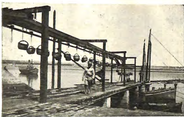
Entladung an unserer Privatbrücke und Transportierung der Körbe mittels einer elektrischen Transportbahn
