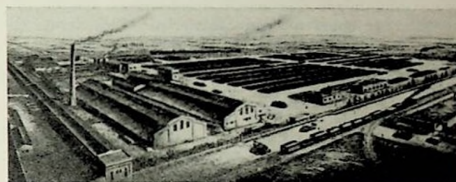
Instalações em Sevilha da Companhia Exportadora Espanhola, com capacidade de refinação de 120 ton. diárias
