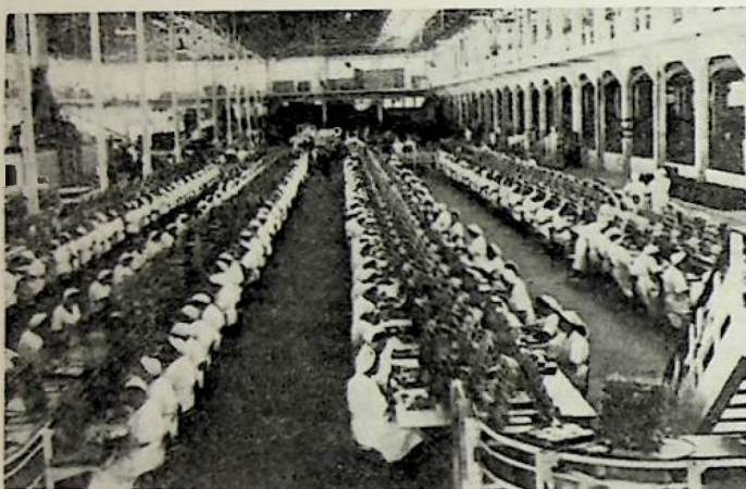
Aspecto parcial da fábrica Massó Hermanos. À esquerda e no fundo vê-se parte do túnel de cozimento por ar quente que se menciona no texto
