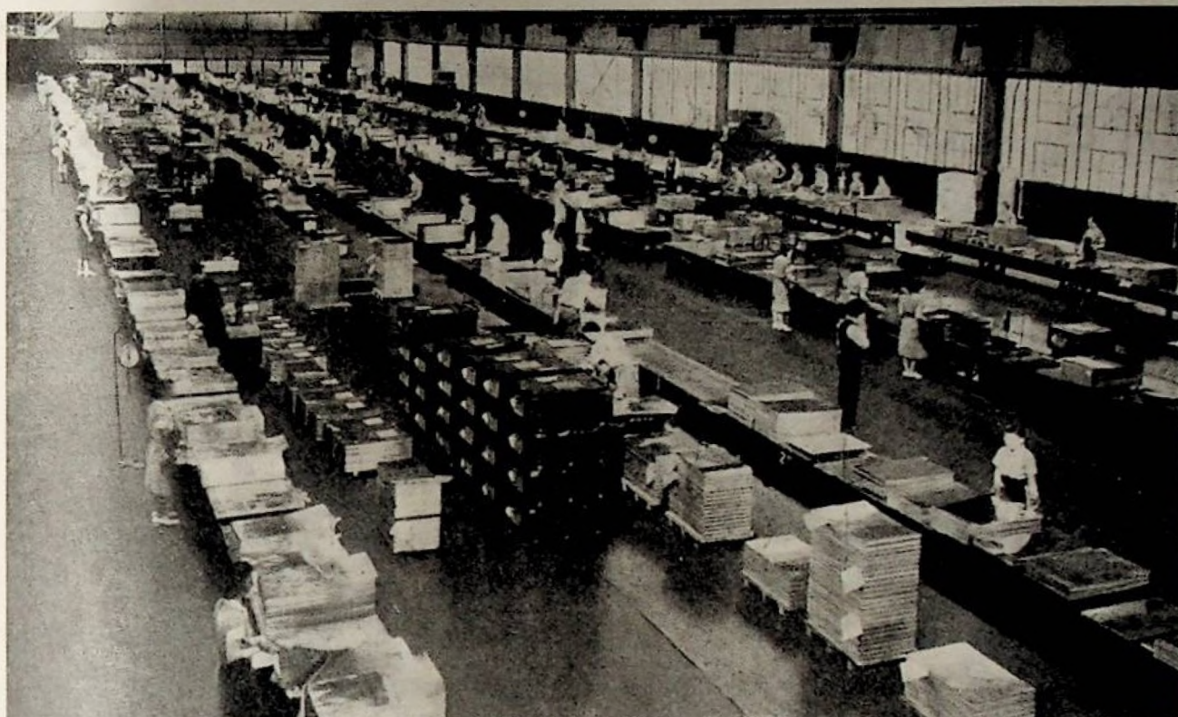
Vista geral da sala de classificação da Folha de Flandres. Aqui se vê a inspeção da folha com acabamento por imersão a quente, para verificação da superfície
