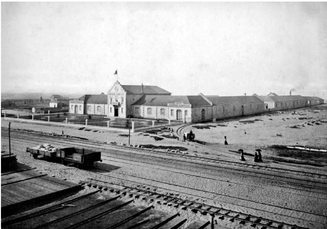
Doc. 7 – C.M.E. – Vista da Fábrica Brandão Gomes com a ligação por via-férrea à Linha do Norte, 1910.
