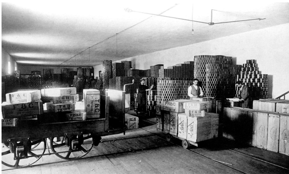
Doc. 12 – C.M.E. – Armazém das expedições com os carris que fazem a ligação com a linha férrea, 1897. Fotografia de Emílio Biel.
