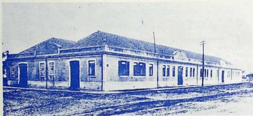
Fachada da Fábrica JUAN PÉREZ LAFUENTE
