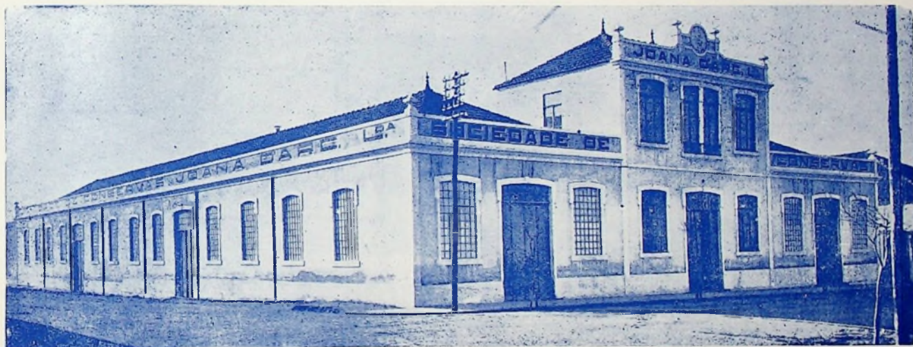
Aspecto exterior da Fábrica JOANA D'ARC, L.da
