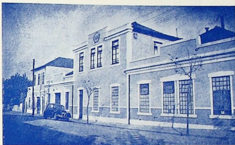
Fachada da Fábrica
