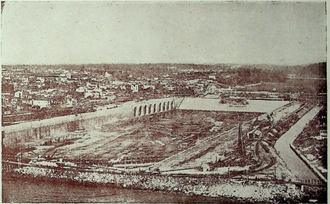
DOCA DE LEIXÕES, quando em construção
