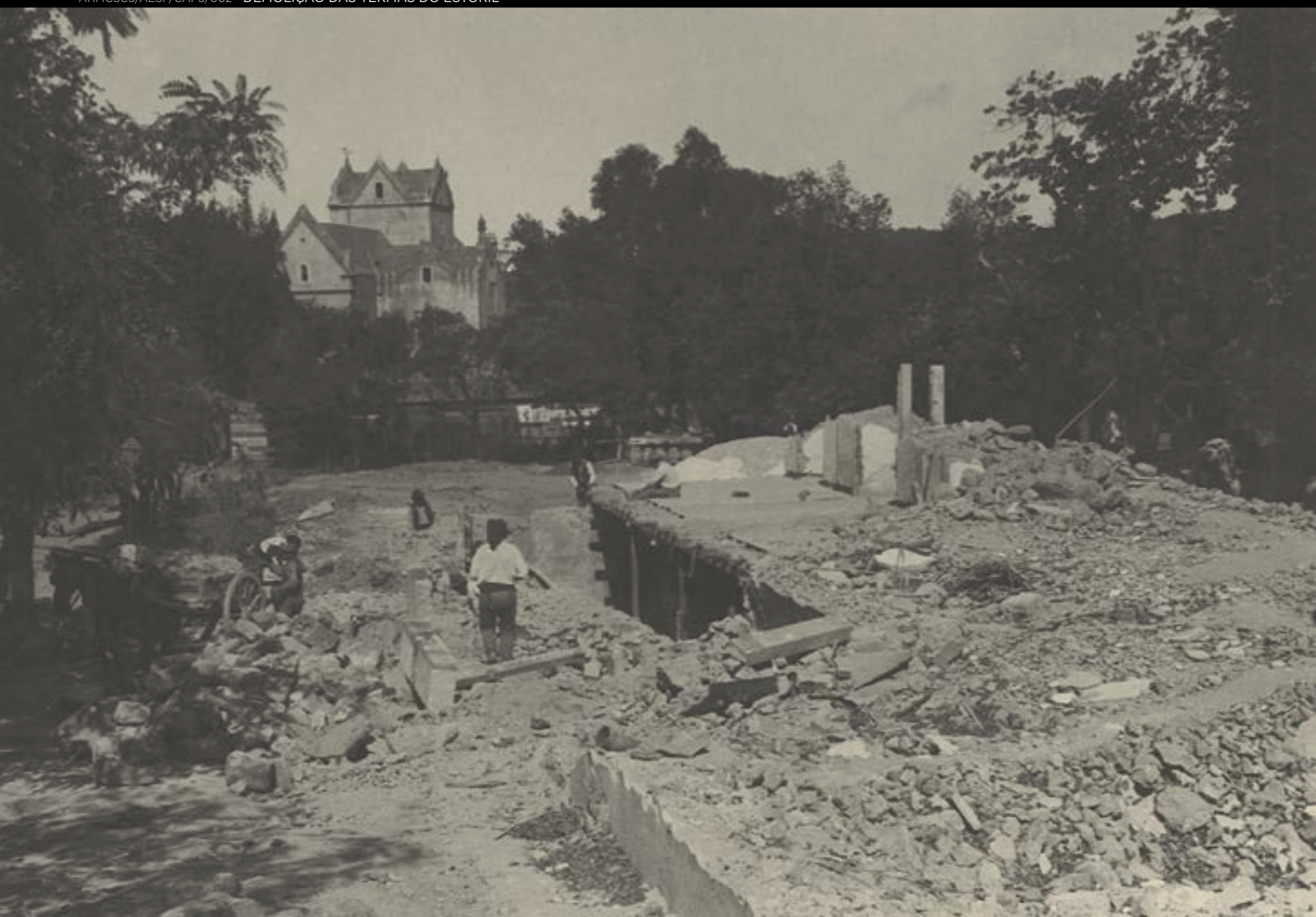
AHMCSCS/AESP/CAFS/002 - DEMOLIÇÃO DAS TERMAS DO ESTORIL
