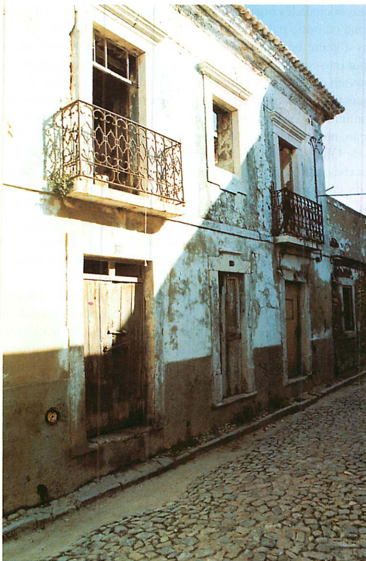
A SEGUNDA RESIDÊNCIA DE ANTÓNIO JACINTO FERREIRA NO PRIMEIRO ANDAR DA RUA ALEXANDRE HERCULANO, 18
